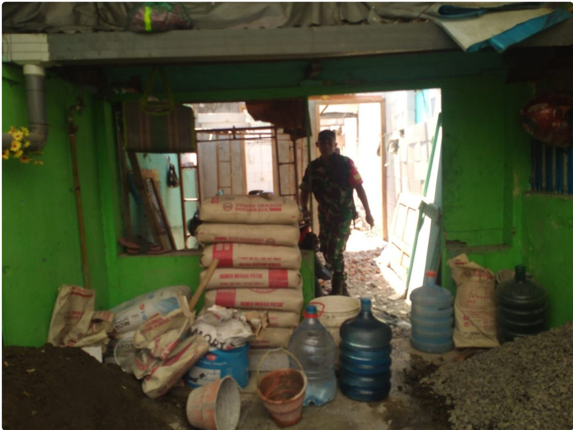
Seperti halnya yang dilakukan oleh Babinsa Koramil 0831/02 Tambaksari Kodim 0831/Surabaya Timur Serka Ferry melaksanakan pendampingan Pembangunan Rumah Tidak Layak Huni (RTLH) milik Bapak Didik Sudjtmiko.
